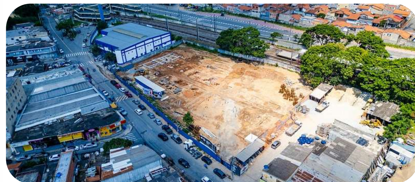
Início das Obras da Escola Estadual Vitápolis
