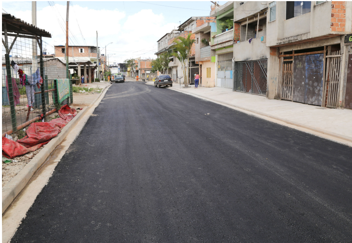
Durante as obras, foram utilizadas 400 toneladas de massa asfáltica
