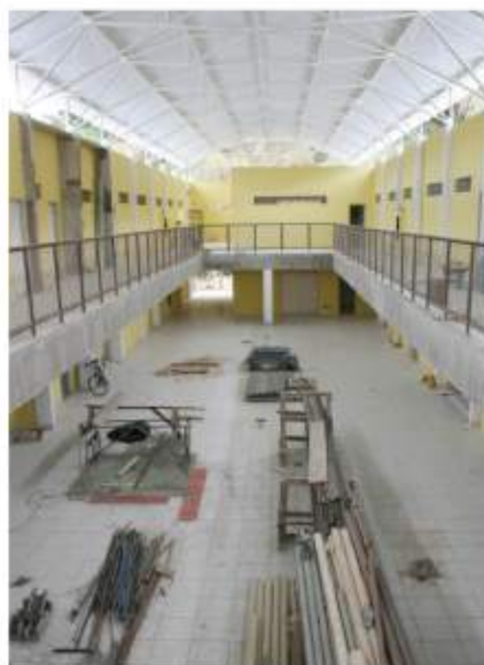
Prefeitura também trabalha na construção da nova sede da E.M. Algodão Doce
