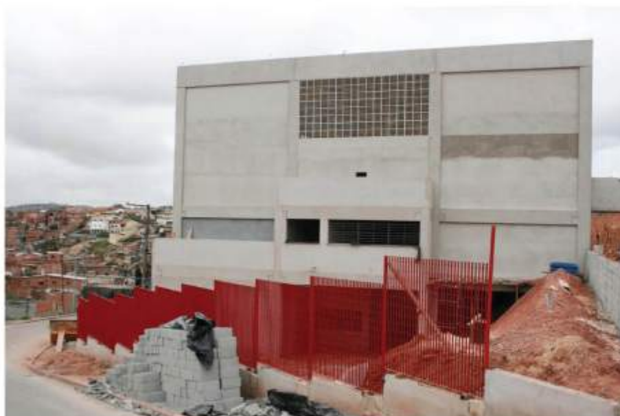
Construção do CEMEB Jardim São Carlos prossegue a todo vapor
